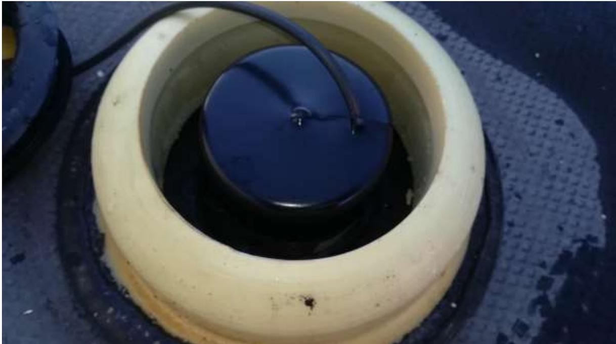
19.) Protector in die Einbauöffnung einsetzen, bis er auf die Dampfsperre aufsetzt.
