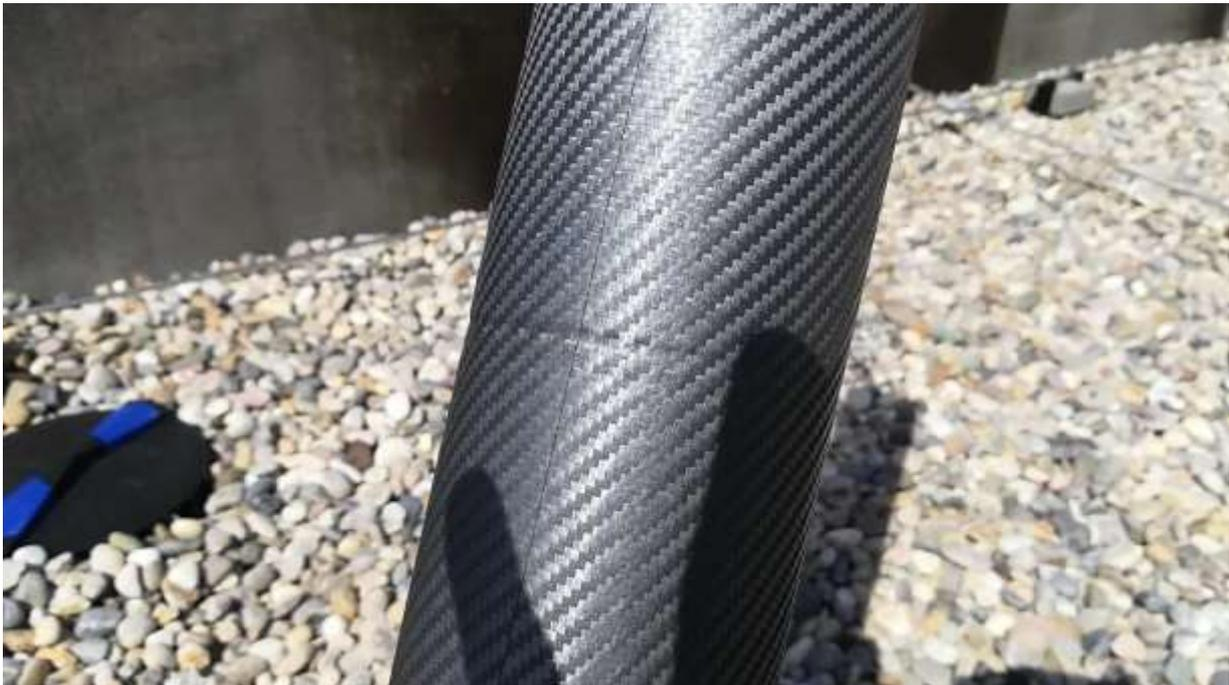
11.) Einbautiefe ermitteln – bei mehrmaligen leichten Kreisen in der Einbauöffnung entsteht eine leichte Kerbung am Protector – diese definiert die Stärke des Dachaufbaues und ist zugleich der Basispunkt für die definierte Einbauhöhe.
