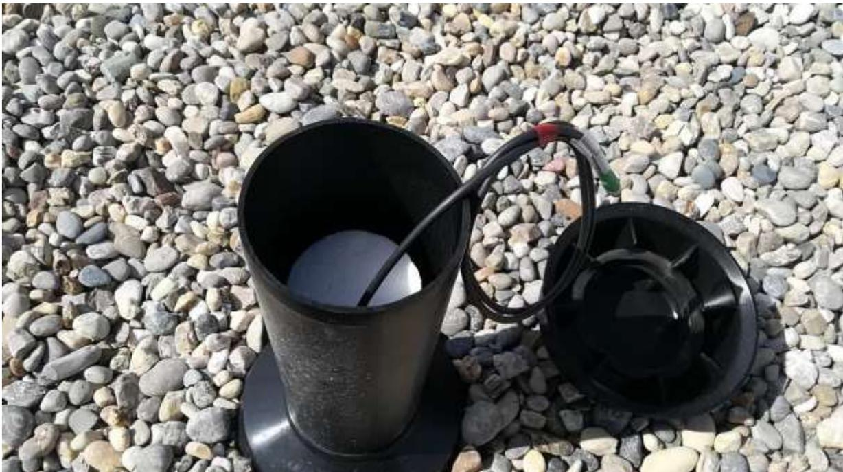
10.) Einbautiefe ermitteln - die Einbautiefe ist so zu wählen, dass der Protector im kompletten Dachpaket verankert wird. Bei Einsatz von permanenten Mess- und Übertragungstechniken, dient die Revisionsöffnung (Flachdachlüfter) als Montageposition, dieser Module (siehe Nachfolgend).
